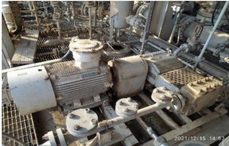
شکل ۲۵. تصویر الکتروپمپ واحد تری اتیلن گلایکول
