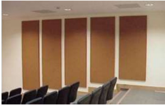
شکل ۱۰. شیوه صحیح کارگذاری جاذب‌ها [۸].
