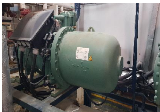
شکل ۱. کمپرسور اسکرو ساخت شرکت بیتزر ۴ کشور آلمان
