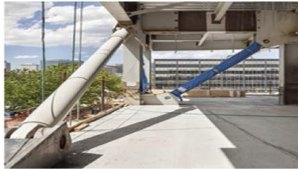
شکل ۱۵. میراگر مغناطیسی مقیاس بزرگ مورد استفاده در ساختمان‌ها [۱۱۴]
