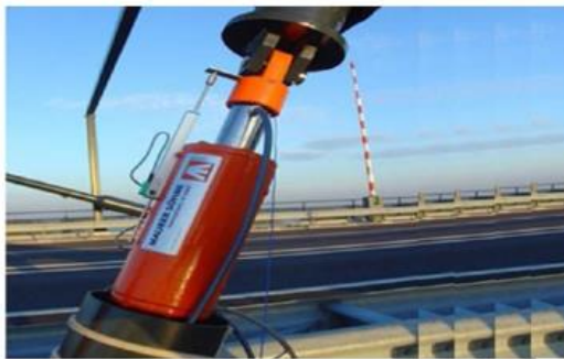
شکل ۱۴. میراگرهای مغناطیسی مورد استفاده در پل‌ها برای کنترل ارتعاشات [۱۱۲، ۱۱۳]
