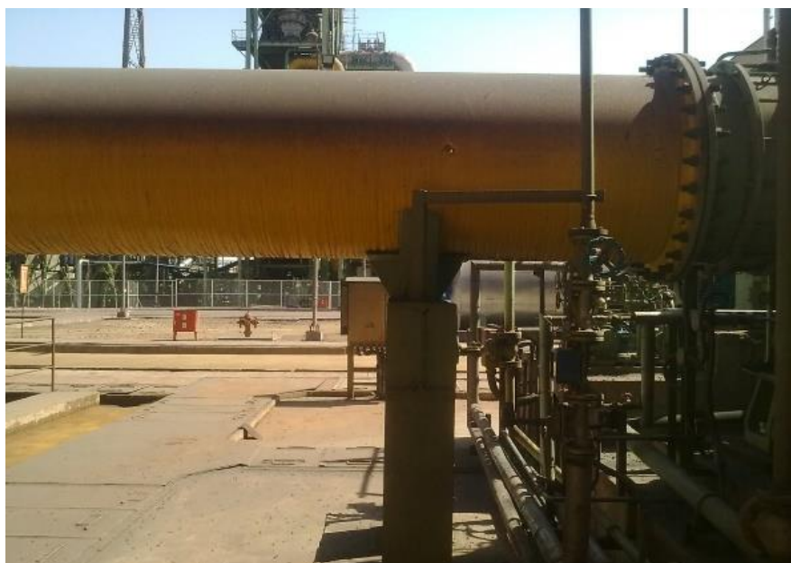
شکل ۱۵. نوع متفاوت تکیه‌گاه کمپرسور ۷۱
