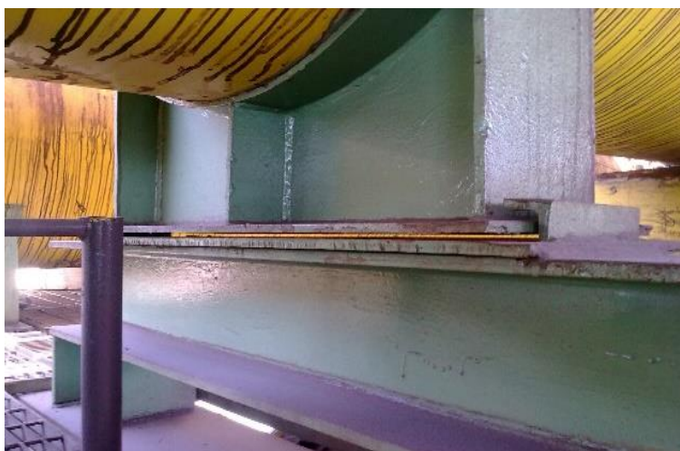
شکل ۲۰. وجود فاصلہ بین تکیہ گاہ و سازه کمپرسور ۷۱
