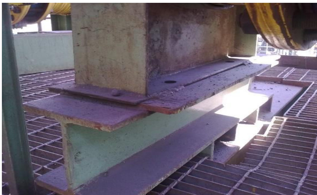
شکل ۱۷. جوش شدن پایه‌ها
