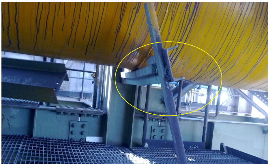
شکل ۲۲. خمیدگی تکیه گاه غیراصولی
