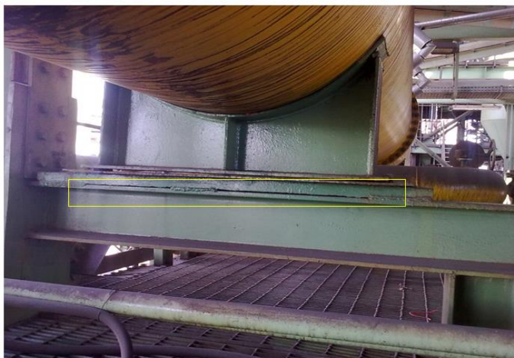
شکل ۱۸. وجود فاصلہ بین سازه کمپرسور ۴۸ و تکیہ گاہ
