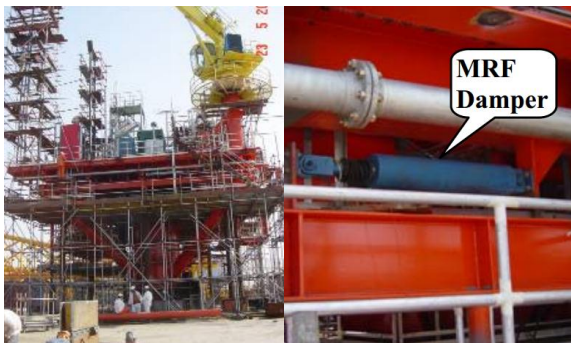
شکل ۱۳. نصب میراگر ام. آر. در سکوی جاکت
