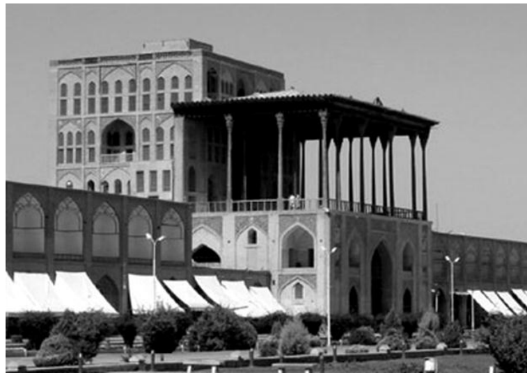
شکل ۱. نمای خارجی عمارت عالی قاپو
