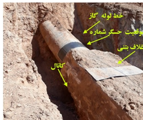
شکل ۱. الف) لوله مورد تحقیق. ب) شماتیک لوله در داخل غلاف بتنی
